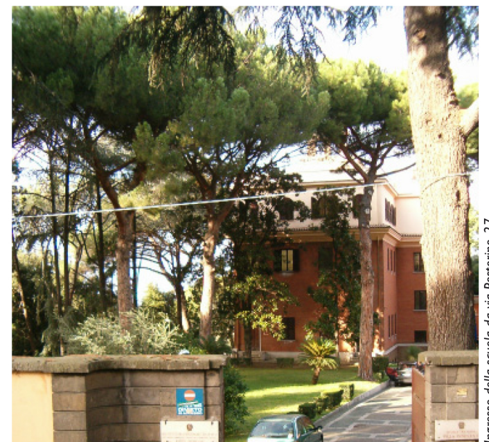
Ingresso della scuola da via Postorino, 27
